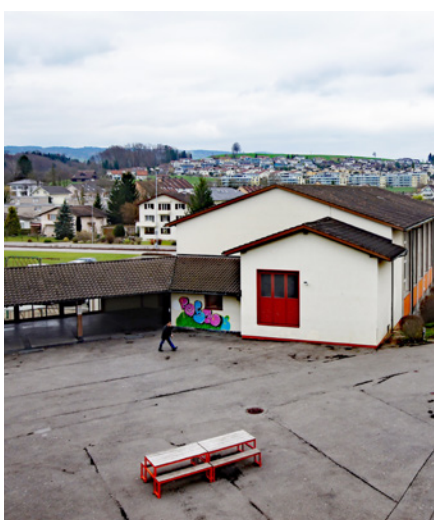
Turnhalle erbaut 1959, abgerissen 2011 für die neue Mehrzweckhalle.
