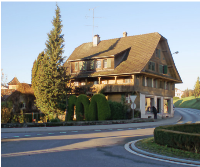
Heute steht an dieser Stelle die Post.
