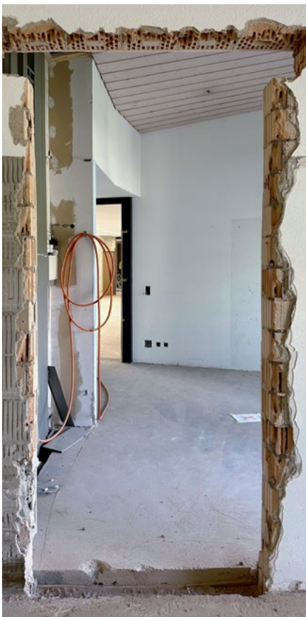
Neuer Durchgang Stationszimmer zum Medi-Zimmer
