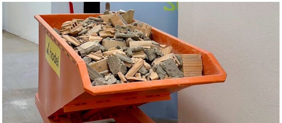
Abbrucharbeiten, Entsorgungskonzept am Bau
