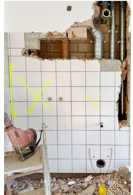
Spitzarbeiten zur späteren Anpassung / Optimierung der Abluft
