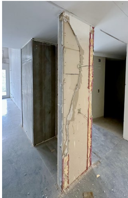
Rückbau der alten Zimmerfronten und Einbauschränke
