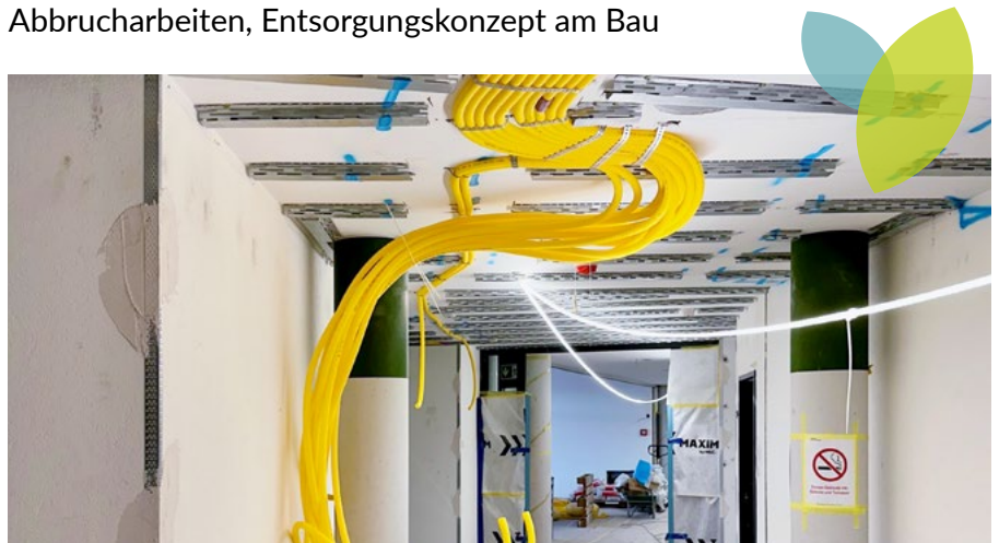
Verrohrung für die neue UKV- und Lichtinstallationen im Korridor
