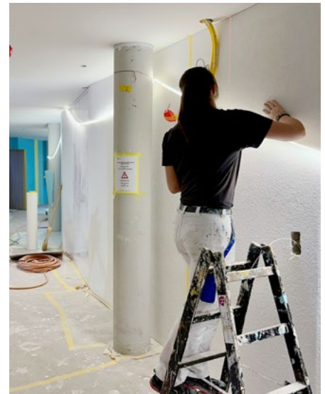
Vorbereitungsarbeiten durch die Malerin im Korridor
