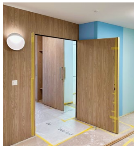
Neue Brandschutzfronten, Korri- dorbeleuchtung und Farbanstrich im Korridor
