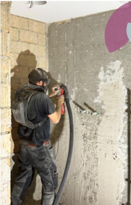
Der bestehende Grundputz in den Nasszellen wird durch Schleifen entfernt
