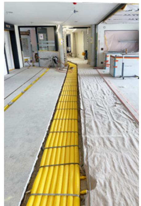
Elektrozuleitungen über den Korridorboden (UKV-Installationen)
