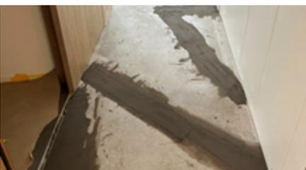
Verspachtelung der Bodenschlitze vor dem Einbau des Vinylbelags
